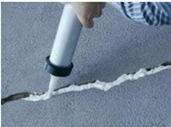
**Полиуретановые однокомпонентные мастики-герметики** - Однокомпонентные полиуретановые герметики обладают следующими характеристиками: являются однокомпонентными, значит, исключено нарушение в технологии при смешивании компонентов; не содержат растворителей, поэтому при герметизации не дают усадки; характеризуются большой прочностью,
